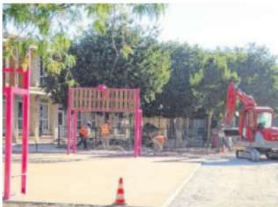
La cour en plein travaux. /PHOTO J.R.
